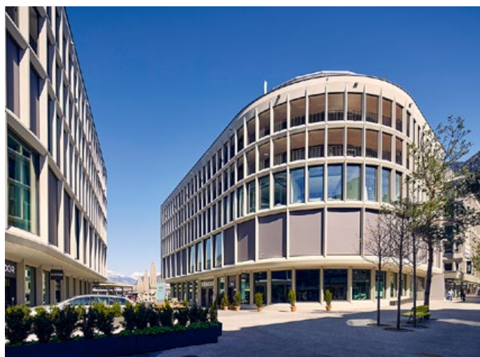
Grazie alla soluzione di climatizzazione proposta da Meier Tobler, le temperature nel centro commerciale «Steinbock» sono gradevoli anche d'estate.
